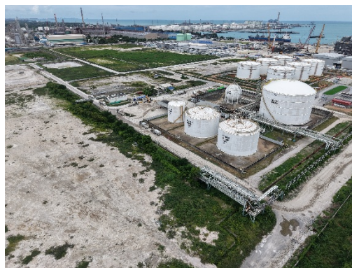
รูปที่ 2-29 คั่นกันคอนกรีตโดยรอบถังเก็บกรดซัลฟูริก
