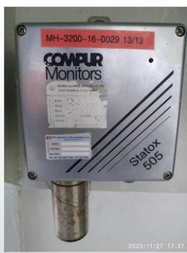
รูปที่ 2-34 ระบบ Ammonia Gas Detector
