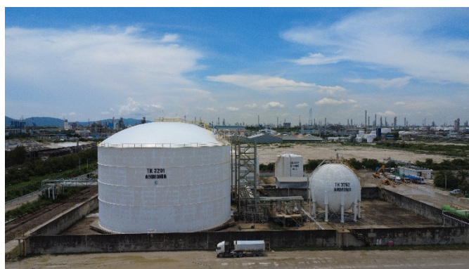
รูปที่ 2-28 การติดตั้งม่านน้ำและคันกันคอนกรีตโดยรอบถังเก็บแอมโมเนีย
