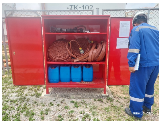
รูปที่ 2-22 การตรวจสอบอุปกรณ์ป้องกันและระงับอัคคีภัย
