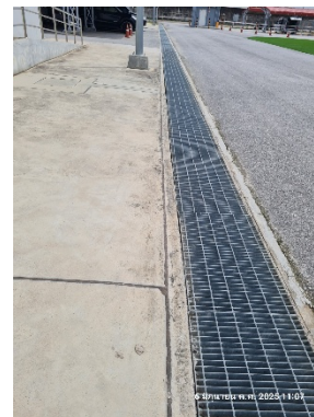
รูปที่ 2-4 รางระบายน้ำฝนภายในพื้นที่โครงการ
