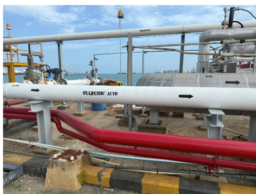
รูปที่ 2-32 การติดตั้งป้าย สัญลักษณ์และข้อความเตือนต่าง ๆ บริเวณแนวท่อขนส่งกรดซัลฟูริกและแอมโมเนีย
