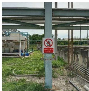
รูปที่ 2-32 การติดตั้งป้าย สัญลักษณ์และข้อความเตือนต่าง ๆ บริเวณแนวท่อขนส่งกรดซัลฟูริกและแอมโมเนีย
