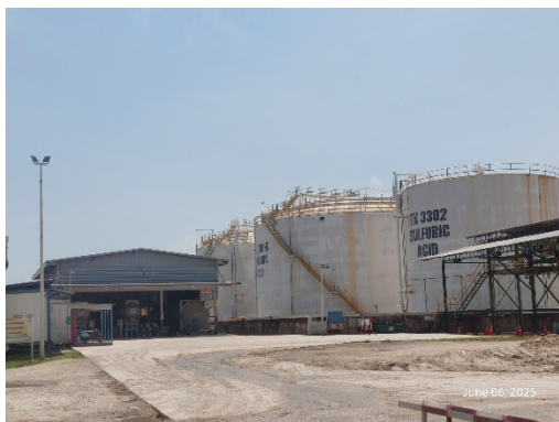
รูปที่ 2-29 คั่นกันคอนกรีตโดยรอบถังเก็บกรดซัลฟูริก
