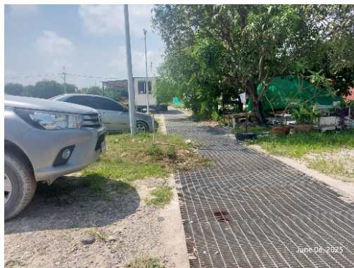
รูปที่ 2-4 รางระบายน้ำฝนภายในพื้นที่โครงการ
