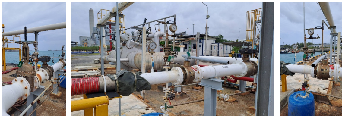
รูปที่ 2-33 การติดตั้ง Block Valve ความคุม
