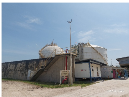
รูปที่ 2-28 การติดตั้งม่านน้ำและคันกันคอนกรีตโดยรอบถังเก็บแอมโมเนีย
